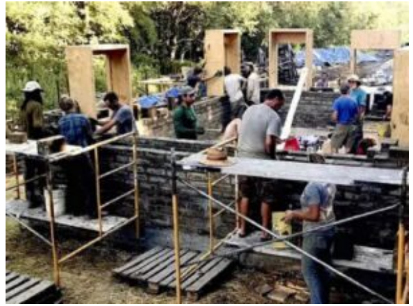
Autoconstruction de maison
